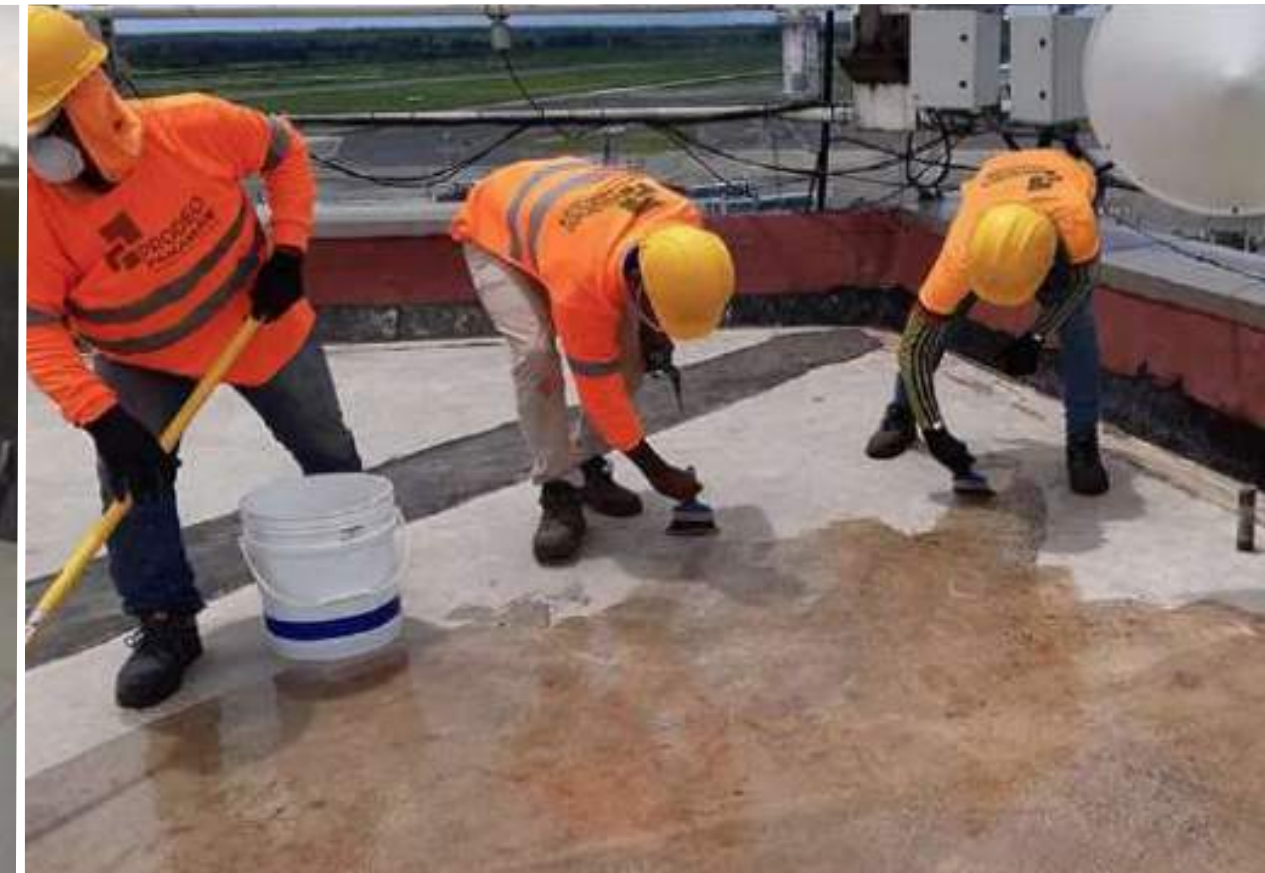
Cubierta Torre Control Tocumen
