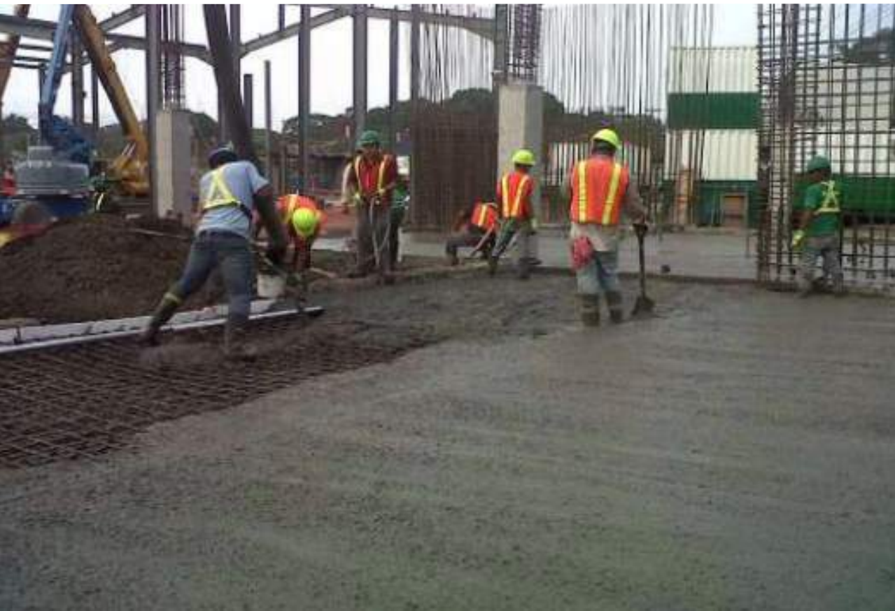
Losa sobre piso
