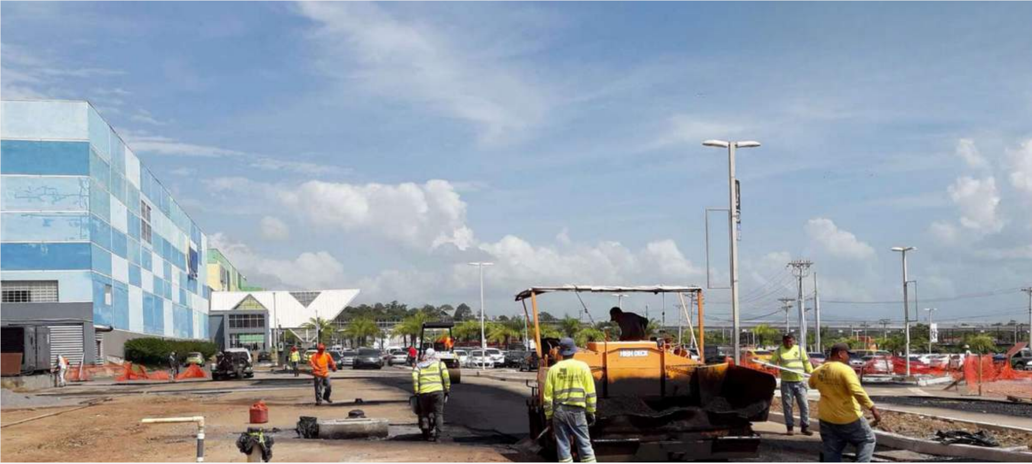
Pavimentación asfáltica (24 de diciembre)
