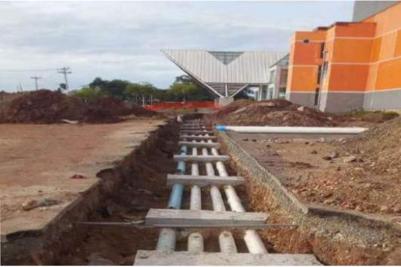
Canalizaciones enterradas
