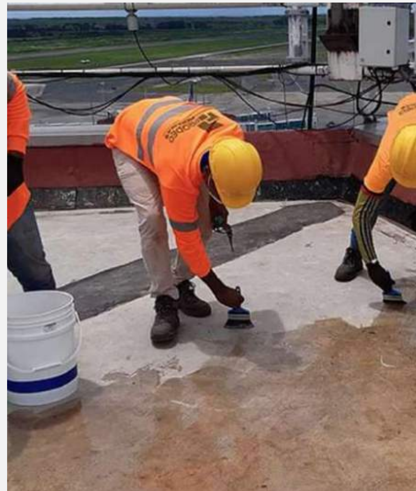
Impermeabilizaciones
