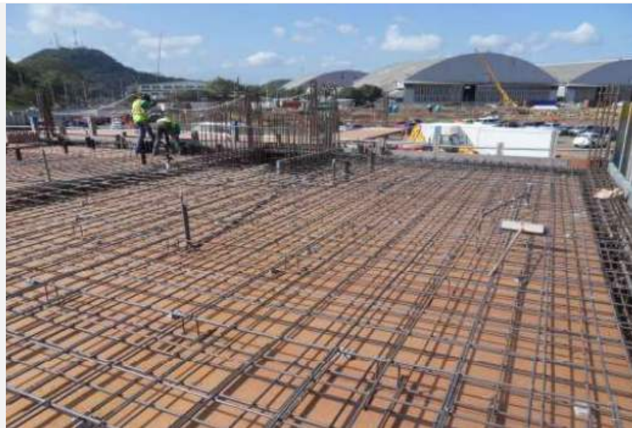
Forjados concreto armado
